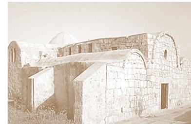
Si presenta con pianta rettangolare e abside sporgente rivolta ad oriente, è costruita in blocchi di arenaria probabilmente provenienti dalle mura dell'antico abitato punico di Tharros.
