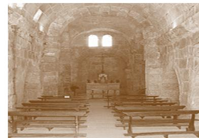
L'interno è organizzato in tre navate separate da tre archi in successione e coperte da volte a botte. In corrispondenza della navata centrale e dell'unica abside compare una piccola cupola, sostenuta da grossi pilastri.
